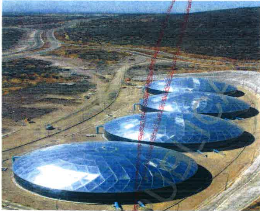
Ilustración 15. Tanques vitrificados con domo geodésico
