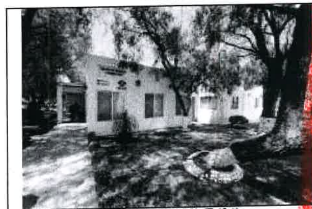
EDIFICIO PRINCIPAL (T-19.1)
