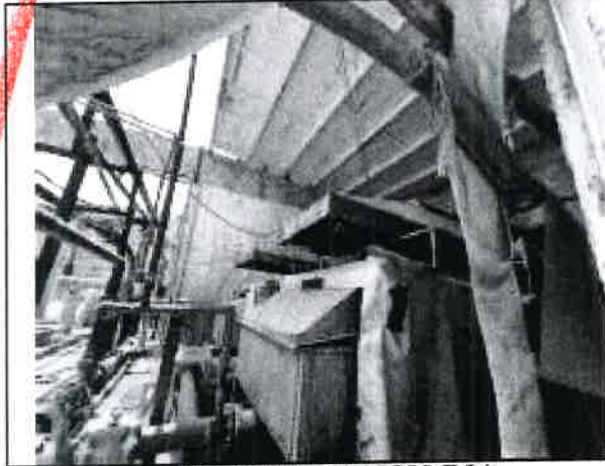
INTERIOR PLANTA DE LODOS (T-5.1)
