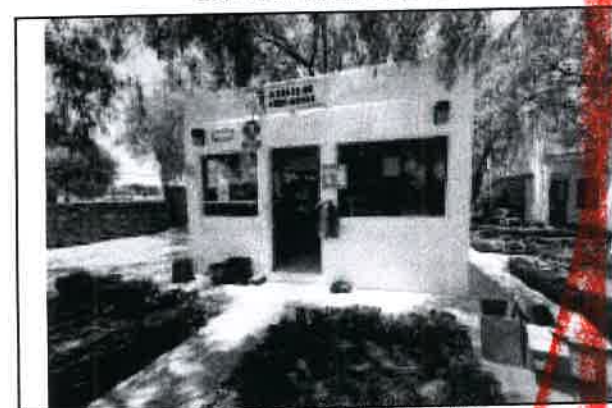
CASETA DE VIGILANCIA (T-18.1)
